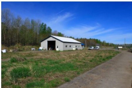
Bâtiment administratif et garage
