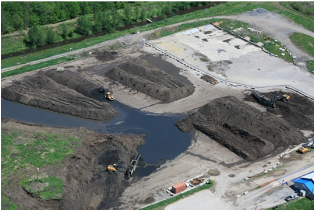
Juin 2012. Aperçu de la plateforme qui se vide de jour en jour.
