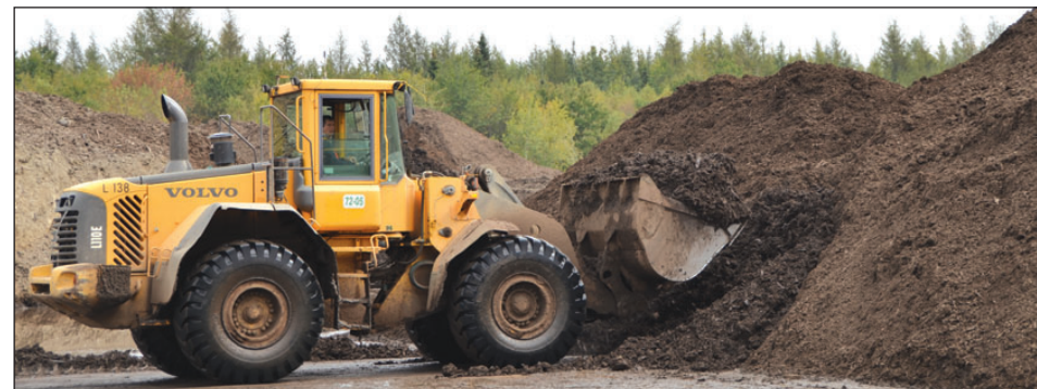
Débutés en juillet 2010, les travaux de nettoyage du site de Compostage Maurice devraient se conclure dans deux ans.
